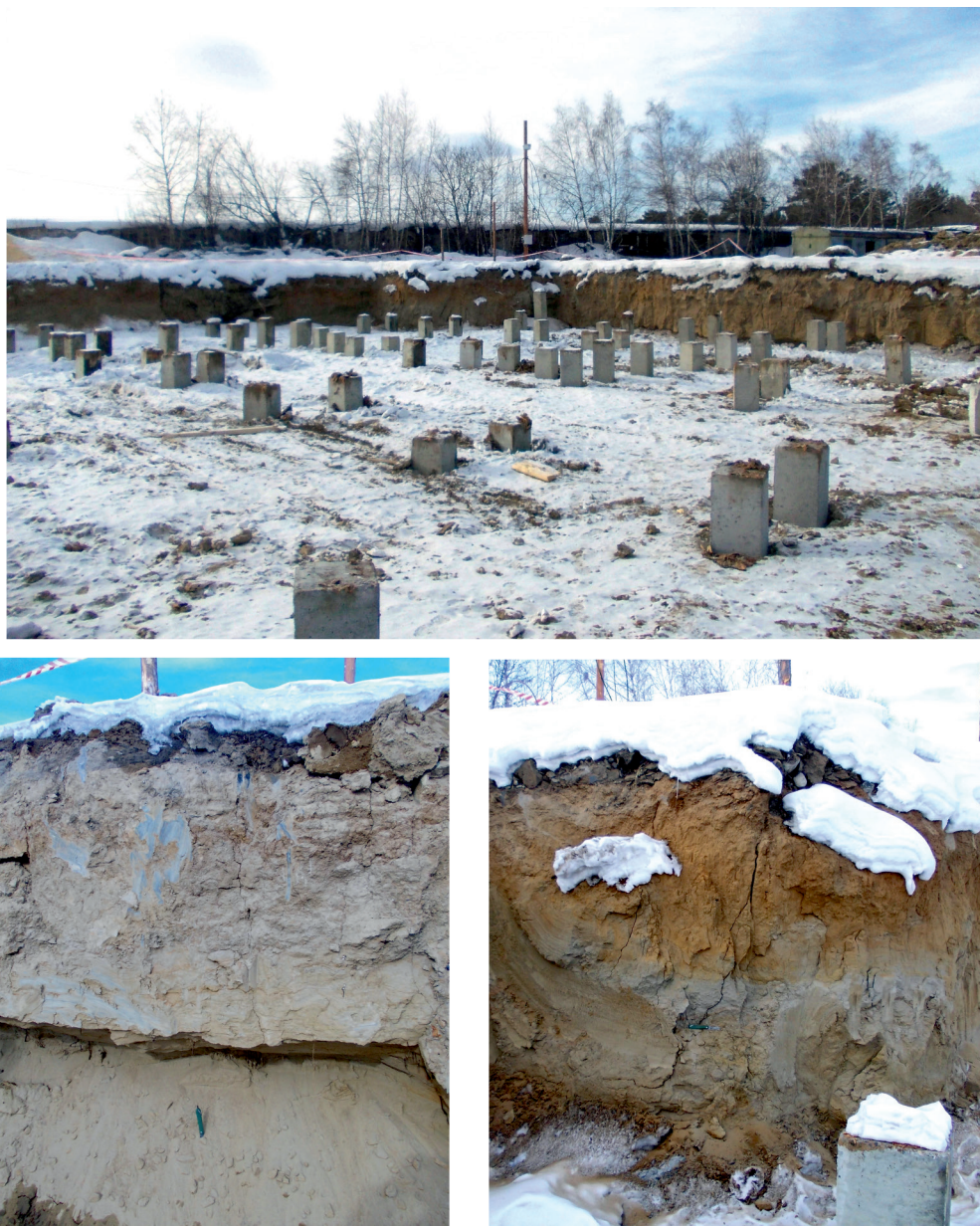
Рис. 1. Общий вид котлована и его стенок, из которых были отобраны образцы верхней зоны разреза аллювиального комплекса
