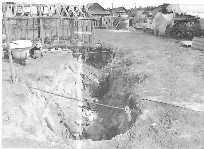
Рис. 3. Форма провалов земной поверхности в поселке Новая Зырянка (г.Березники, Пермская обл.)
