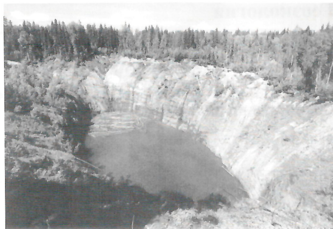
Рис. 2. Провал земной поверхности в районе затопления рудника третьего Березниковского калийного рудоуправления
